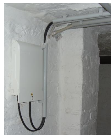
Abbildung 6 Verlegung zum Anschlusskasten (HÜP)
