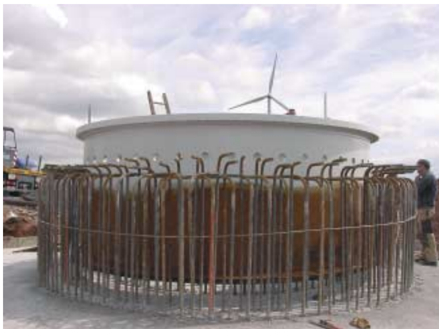
Armierung mit Fundamentsektion für den Stahlurm der Windkraftanlage
