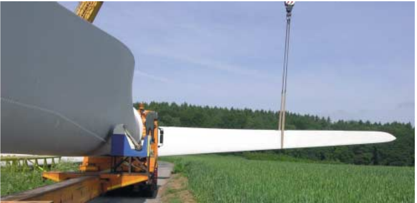
Anlieferung eines Rotorblatts
