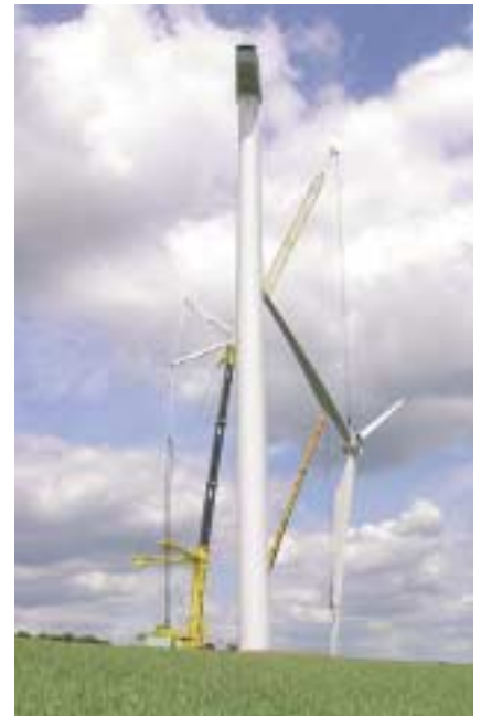
Turmmontage des Rotors
