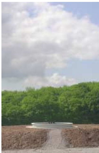
Fundament der Windkraftanlage
