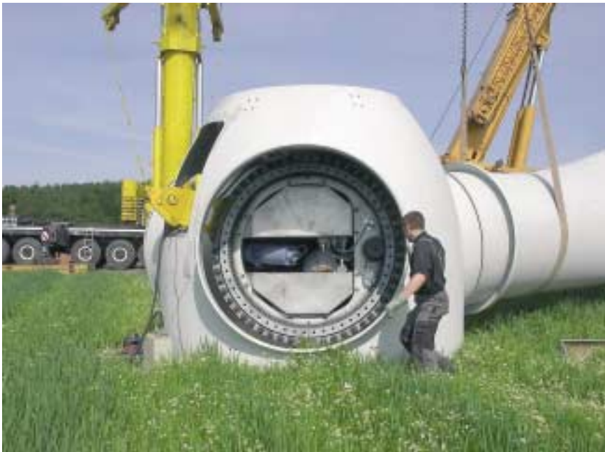
Bodenmontage des Rotors
