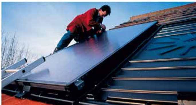
Kollektormontage auf einem Ziegeldach
