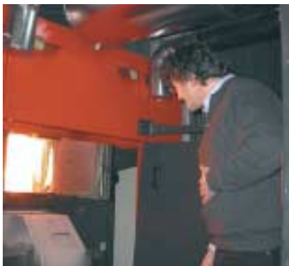
Bürgermeister Dr. Franz Kahle begutachtete den neuen Holz hackschnitzelbrenner
