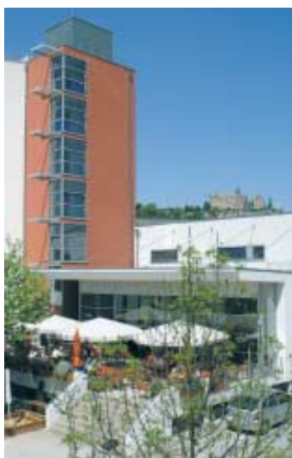
Das Technologie- und Tagungszentrum der Stadtwerke Immobilien GmbH im Marburger Südviertel
