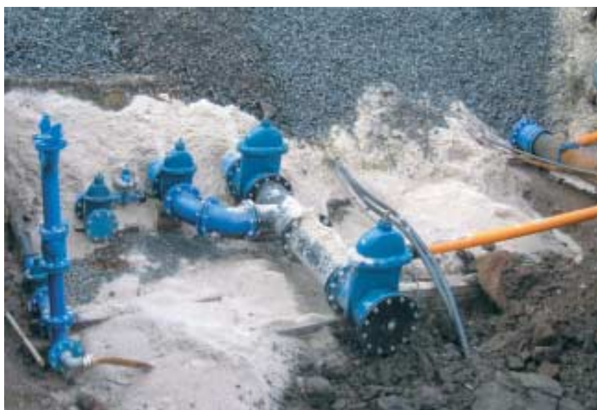
Erneuerung einer Gasmitteldruckleitung
