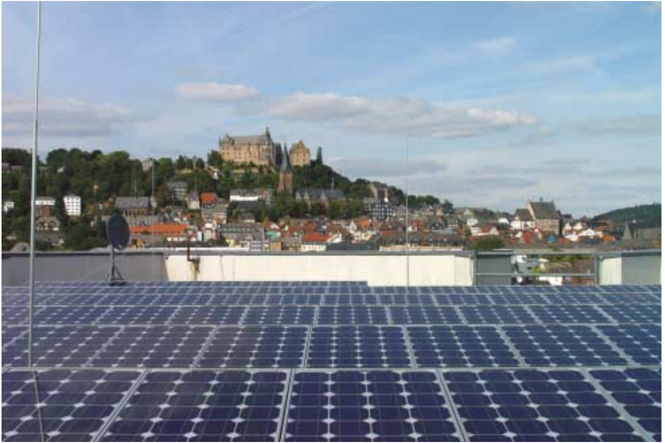
Photovoltaikanlage auf dem Dach des Technologie- und Tagungszentrums
