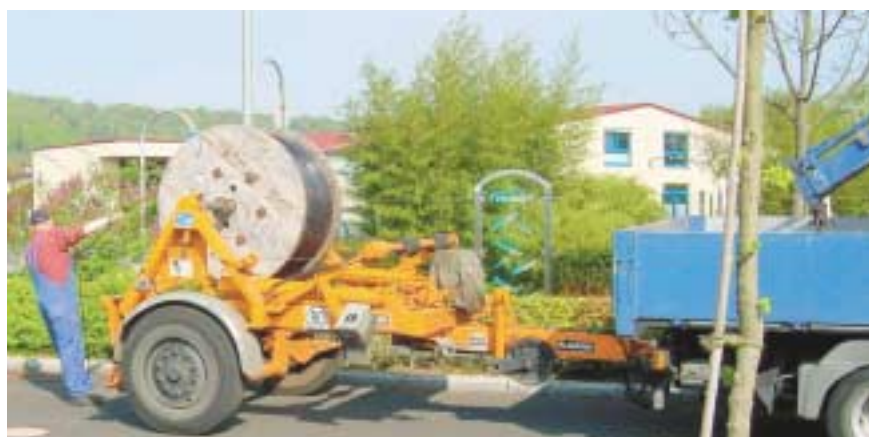
Kabelverlegung im Industriegebiet Cappel
