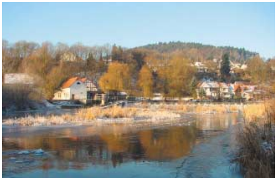
Das Wasserwerk der Stadtwerke Marburg in Wehrda
