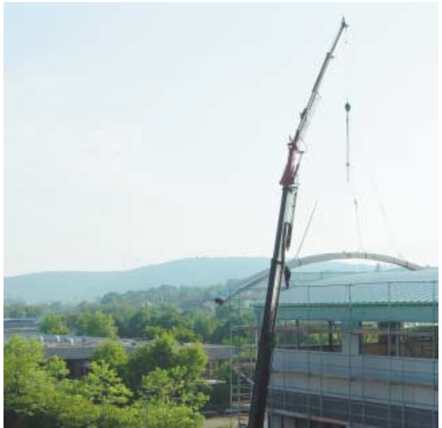
Das Betriebsgebäude Am Krekel wird aufgestockt
