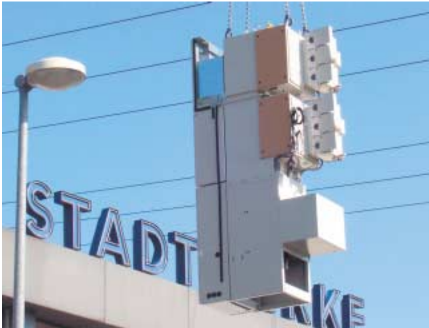
Umbau am Umspannwerk Süd
